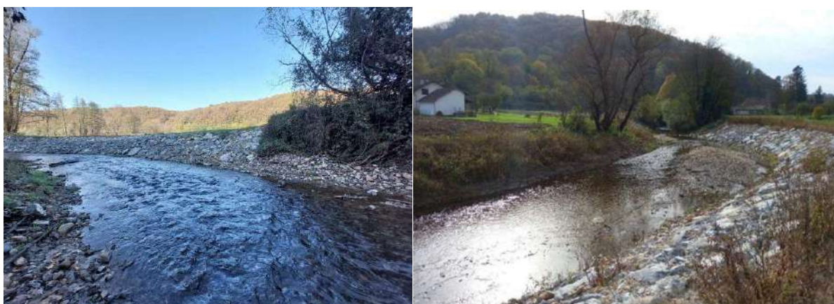
Slika 31 Lokacija 2. Pokos desne obale, studeni 2022 (lijevo) i lokacija 3 pokos desne obale (desno)(Izvor: Hrvatske vode, 2022)
